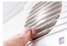
1/ Démontez la grille centrale (laissez le bloc de régulation en place) ;
